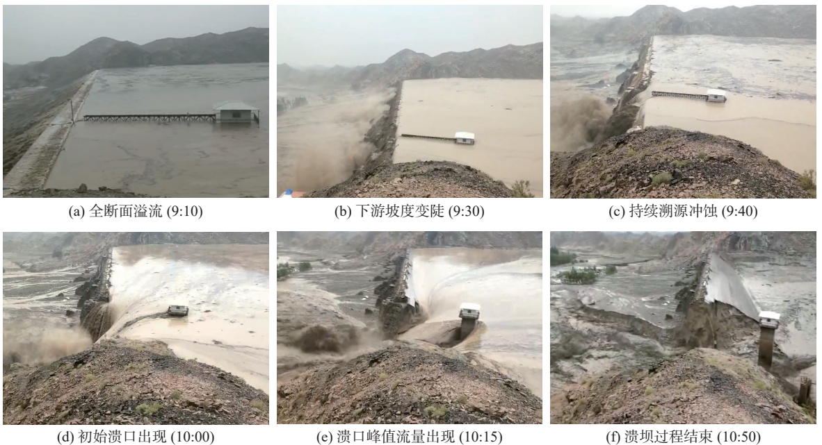
图 8 射月沟溃坝过程照片
